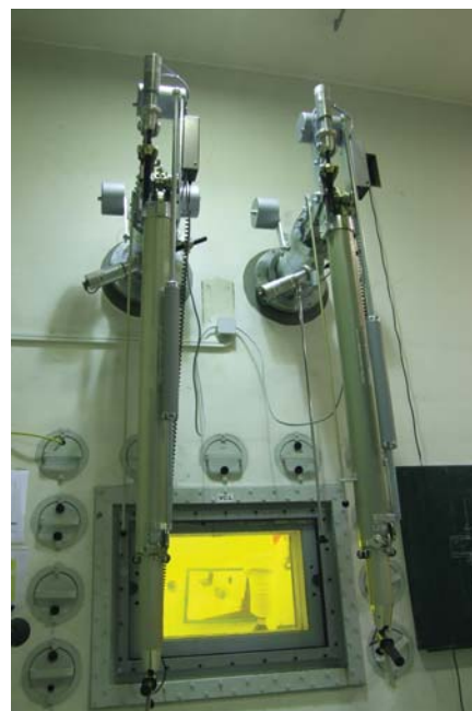
Slika 1: Manipulatorji v objektu Vroča celica
