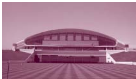
Slika 1: Sapporo Dome – edini v celoti pokrit nogometni in baseball – stadion na svetu. Posebnost stadiona je 120 m × 85 m velik betonski voziček z maso 8300 ton, na katerem "raste" nogometno igrišče, ki se nahaja zunaj stadiona (travniki pred stavbo stadiona na sliki). Pred nogometno tekmo, dvignejo velika dvižna vrata (spodnji del stavbe) in voziček z nogometnim igriščem zapeljejo v notranjost
