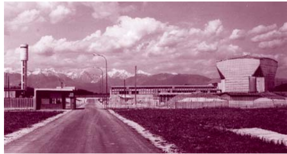
Zgradba reaktorja TRIGA v Brinju
