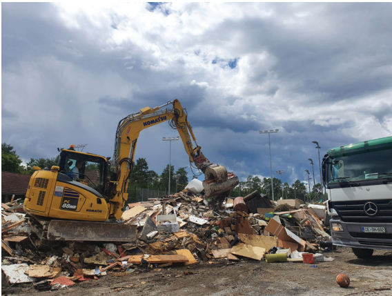
Neskončne količine uničenih delov stavb in opreme, ki jih sproti odvažata lokalna smetarska služba.
