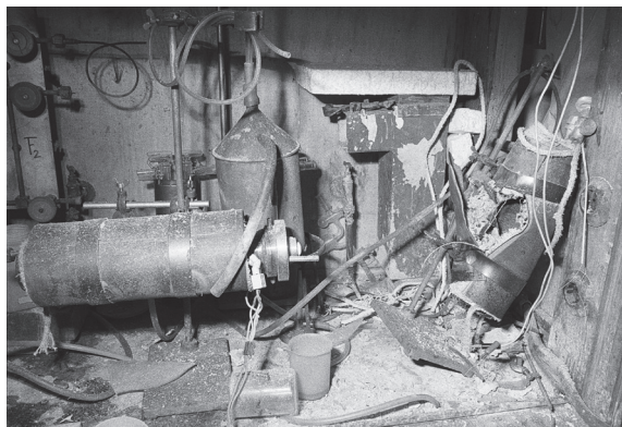
Slika 5: Tudi to se je včasih zgodilo – posledice eksplozije, laboratorij za fluor, mali digestorij
